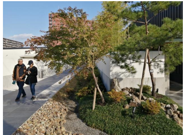
日新電機研修センター(2019年3月～) 雨水を一時貯留し循環・浸透
