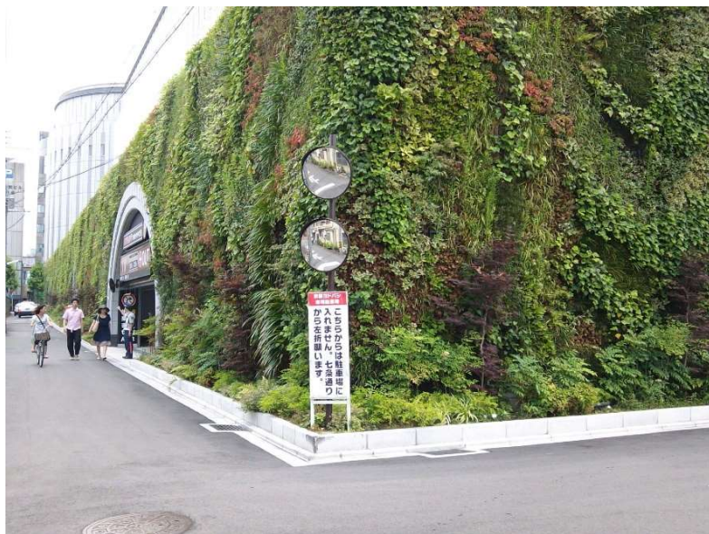
ヨドバシカメラ(高さ7m × 幅160m、総面積1,120㎡) 京のみどり59号(2011年7月発行)より
