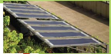
シート型太陽光発電装置
