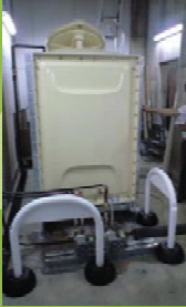
地下湧水貯水タンク
